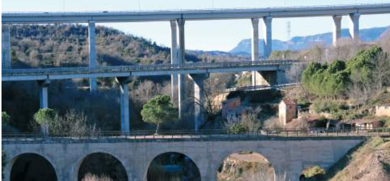
Els tres aqueductes que s'han format amb el pas dels anys: la C-16, l'antiga carretera i la via del carrilet. NIA ESCOLÀ / ACN
