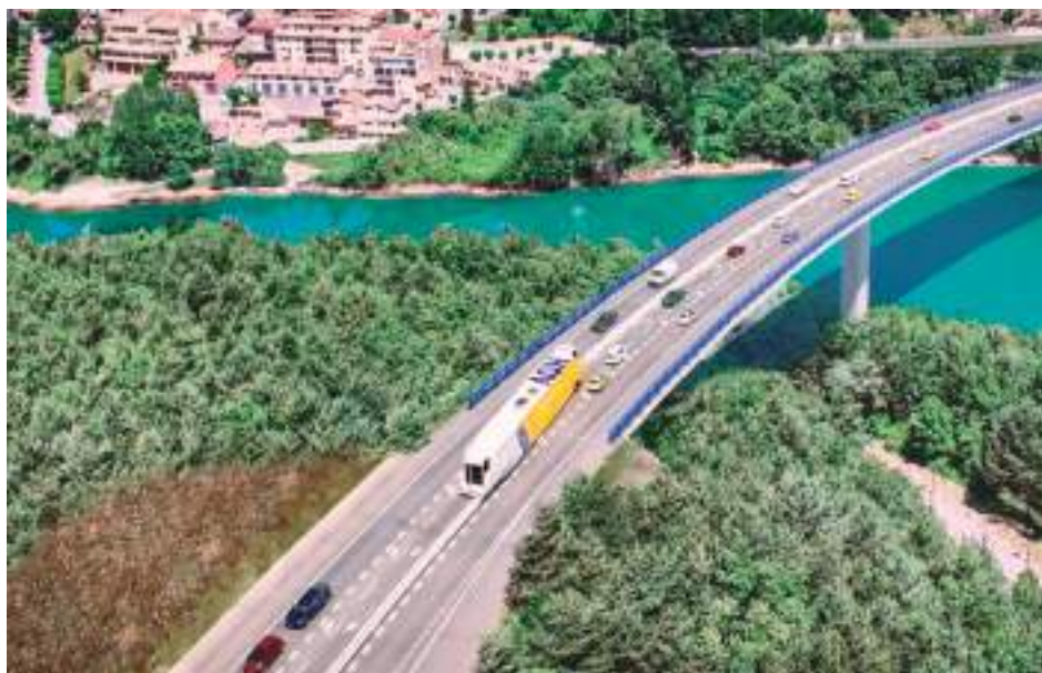
El nou viaducte de Cercs quedarà més apartat del poble i substituirà l’actual, que anirà a terra. TERRITORI
