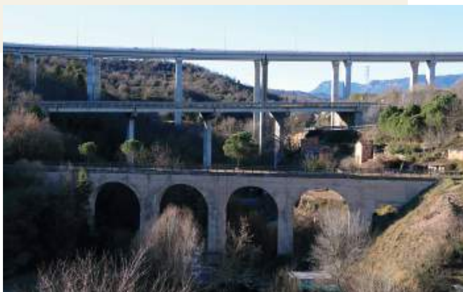
El tram de via verda que ara surt a concurs permetrà crear un itinerari segur entre els Viladomius. ACN
