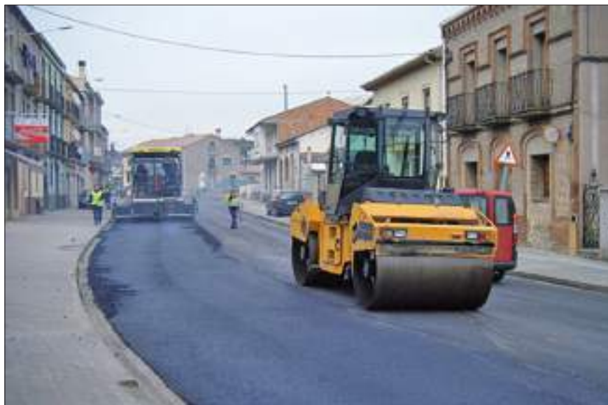
Obres d'asfaltat de la carretera de Bassacs a Gironella, el febrer del 2011. A.J. GIRONELLA
