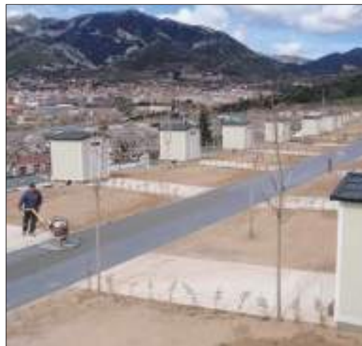
Obres a la zona d'ampliació. BERGA RESORT
