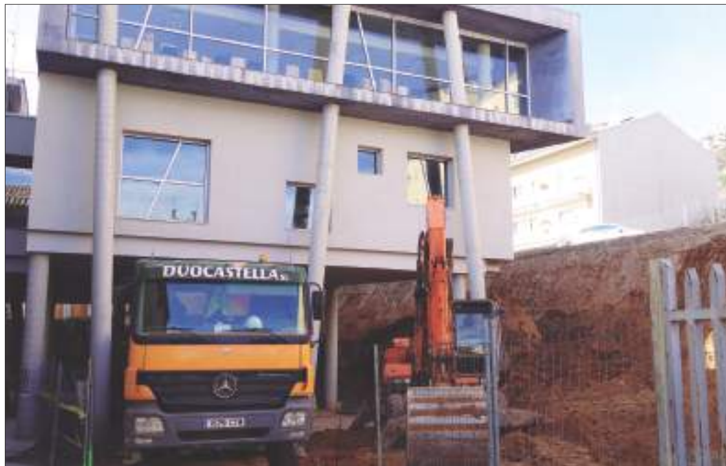
Les obres permetran reconstruir un mur esllavissat ara fa quatre anys a tocar de l'escola de música. RICARD CODINA
