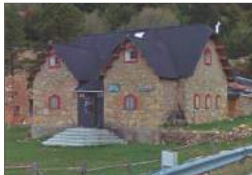
Exterior del refugi-xalet del Rasos. GOOGLE STREET VIEW
