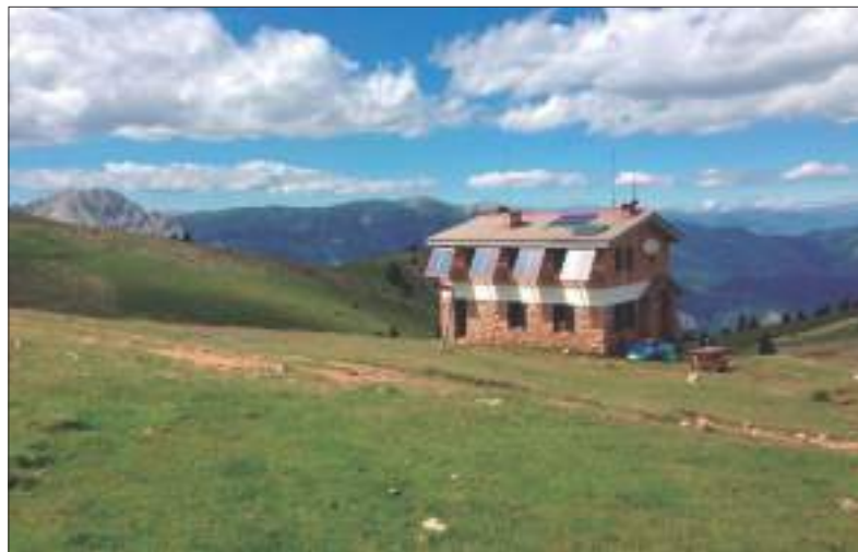
El Refugi Serra d'Ensija ha millorat les instal·lacions aquest estiu. FEEC
