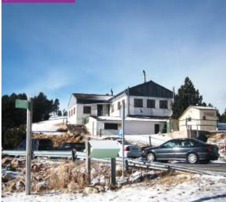
Instal·lacions de l'antiga estació d'esquí dels Rasos de Peguera. JORDI MALANYEU
