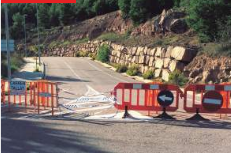
Tanques i senyals indiquen el tall de carretera, a la rotonda de Puig-reig nord. A.COSTA
