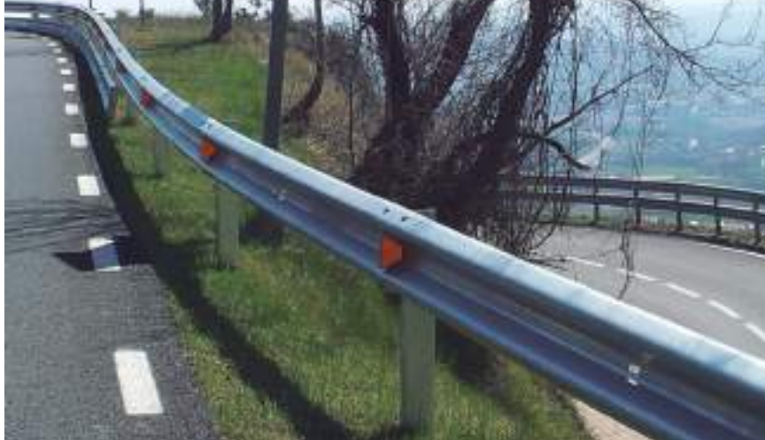
Tanques metàl·liques amb protecció i sense. I doble tanca sense protecció. XAVI GASSÓ
