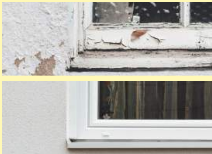
Finestra original i rehabilitada (de dalt a baix)
