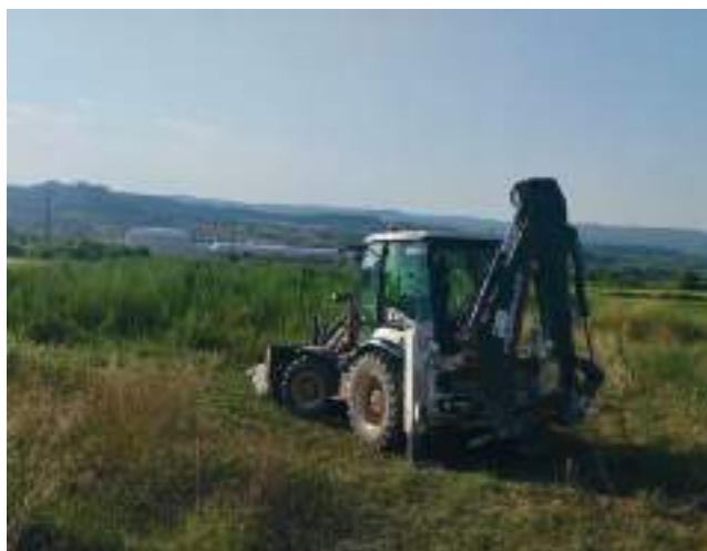
Treballs per a la construcció de la nau al polígon d'Olvan. S. Q.
