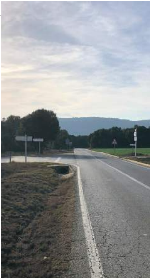
El trencant cap a Montmajor, punt clau de les primeres obres. A.G.
