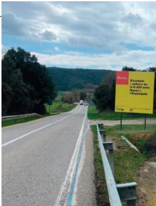
Ja hi ha màquines treballant a la carretera cap a Cardona. TERRITORI
