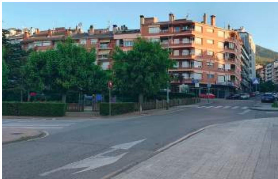
La zona est del barri de la Font del Ros, on està prevista la segona fase de les obres, ja a concurs. AJ BERGA
