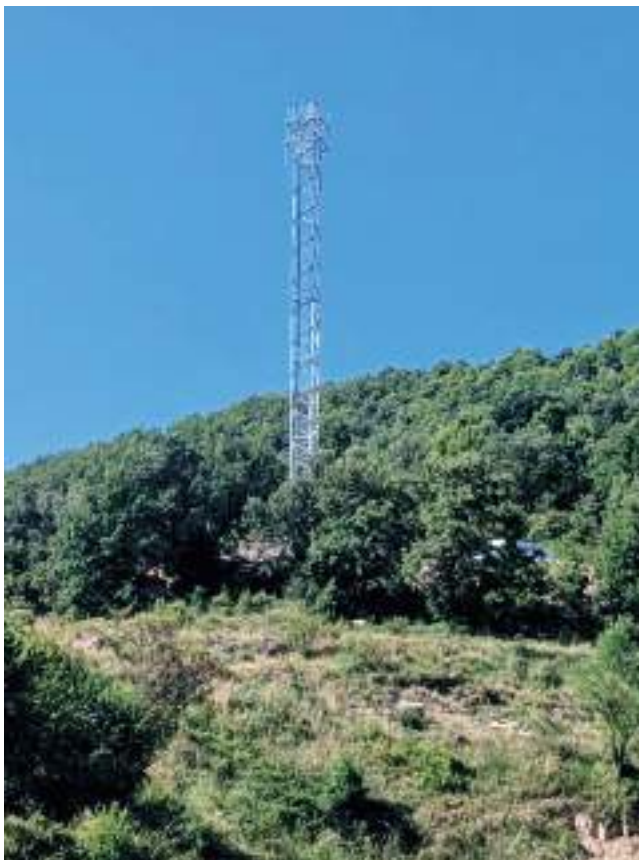
La torre de telefonia, ja ubicada al turó de Cal Sastre de la Costa. M.C.
