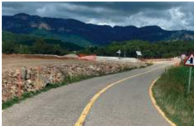
Obres a la carretera que enllaça Montmajor i Cardona. TERRITORI
