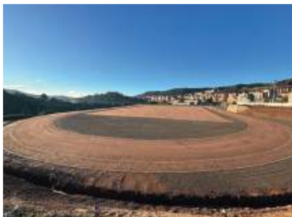
La pista d'atletisme, després de la primera fase d'obres. AJ PUIG-REIG
