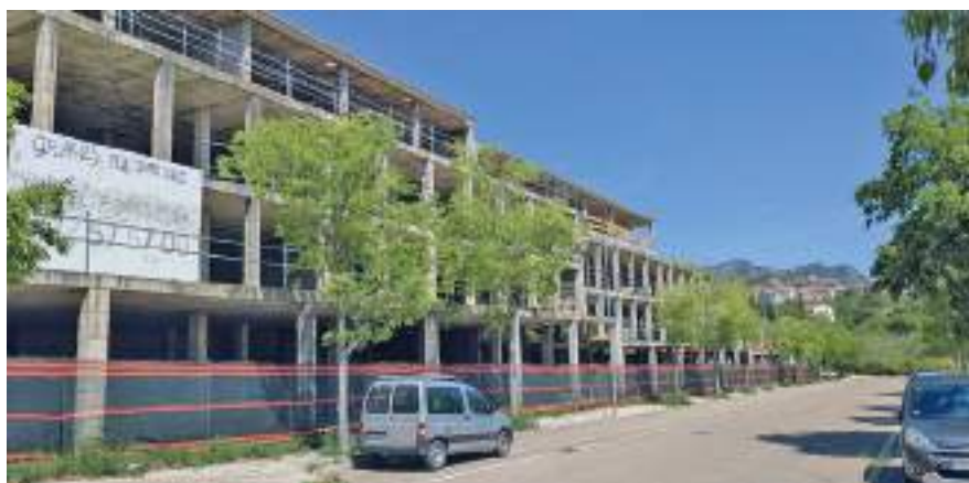
En plena crisi, la construcció dels edificis va quedar a mig fer: només es van enllestir les estructures. M.C.
